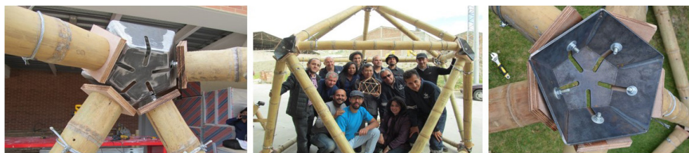
2 Fabricación de Domo con uniones de compresión radial propuestas por Widyowijatnoko, A.
