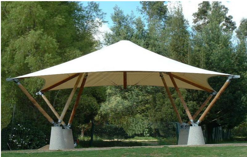
*Figura 9: Espaço com estrutura tensionada, bambu e cabo de aço.
