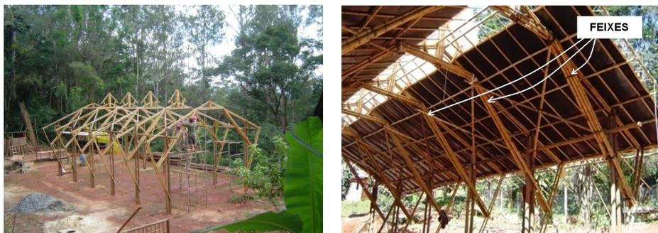
*Figuras 19 e 20: Exemplo de aplicação de colunas em feixe em estrutura.*
