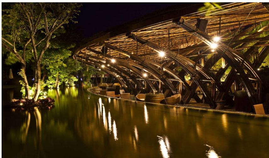
*Figura 21: Aplicação de colunas em feixe de bambu em estruturas arquitetônicas.*
