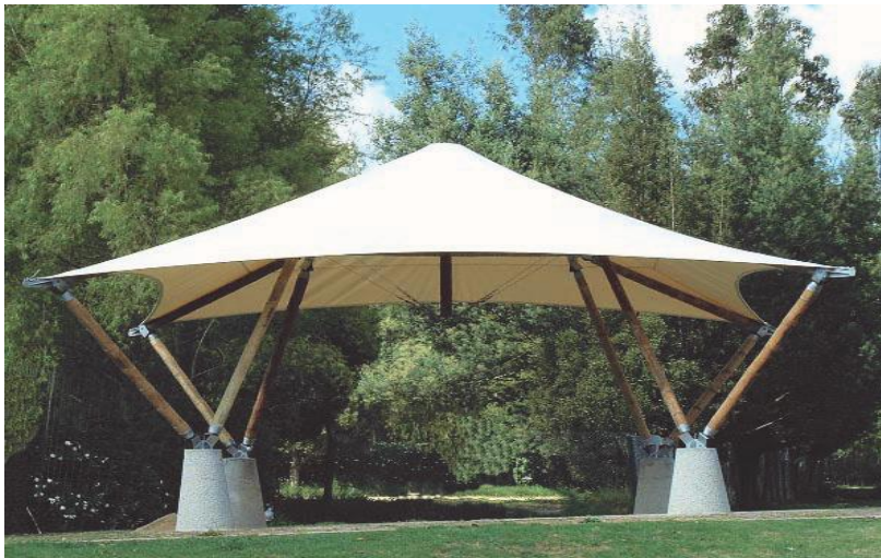
Figura 9: Espaço com estrutura tensionada, bambu e cabo de aço. Fonte: Art World (Maharashtra, India).
