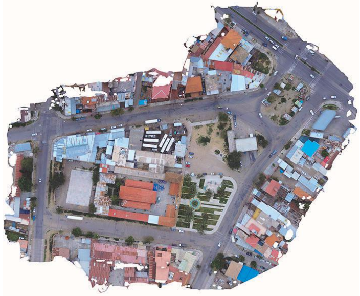
Figura 4. Vista de la zona de emplazamiento para el parque urbano sobre la calle Ollantay, paralela al proyecto mARTadero.
