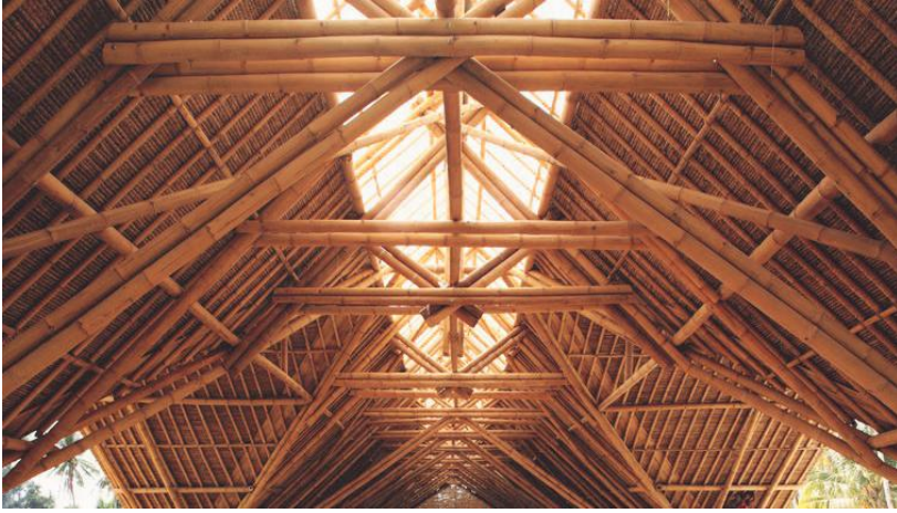
Figura 13: Aplicação de colunas compostas em coberturas.
