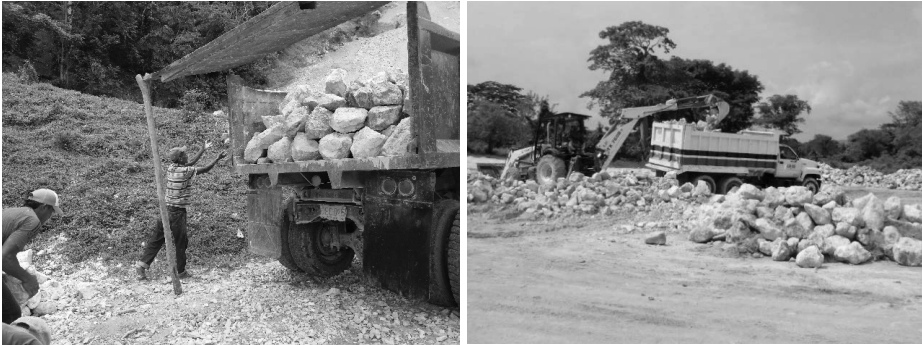
Figura 44. Operación de carga del material del Departamento de Sucre 2016.
