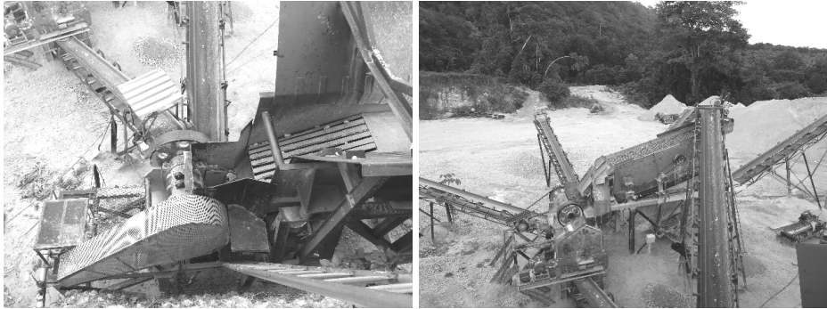
Figura 47. Planta de trituración y clasificación de materiales agregados del departamento de Sucre 2016.
