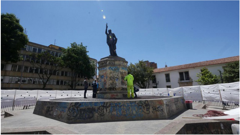
Imagen 4. Estado monumento antes de la intervención. Enero 2017.
