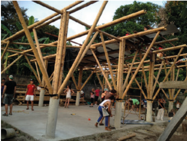
Imagen 2. Casa de la Cultura de Palomino, proceso de construcción.
