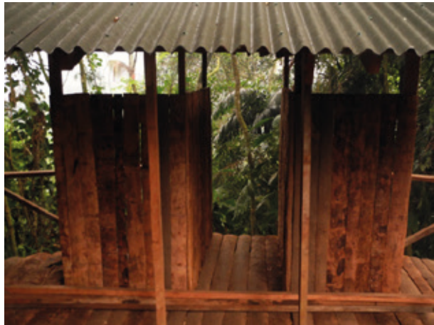
Imagen 24. Cubierta y Baño seco en Ciudad Perdida.
