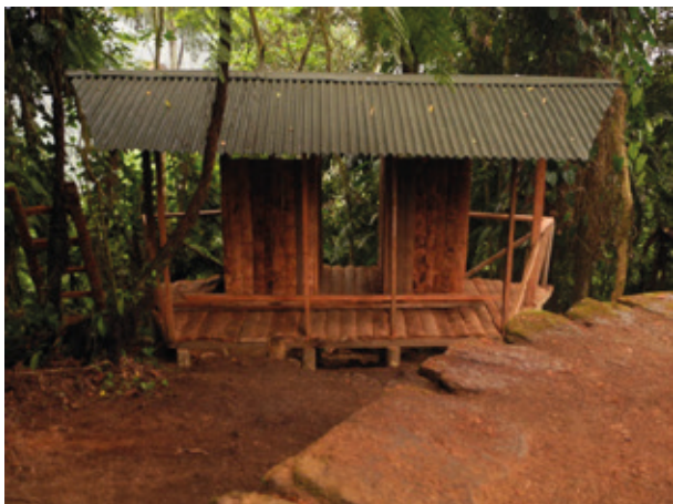
Imagen 19. Cubierta y Baño seco en Ciudad Perdida.
