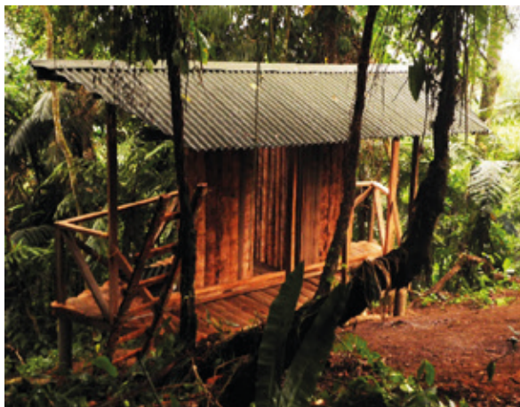
Imagen 20. Cubierta y Baño seco en Ciudad Perdida.
