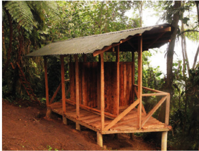
Imagen 18. Cubierta y Baño seco en Ciudad Perdida.
