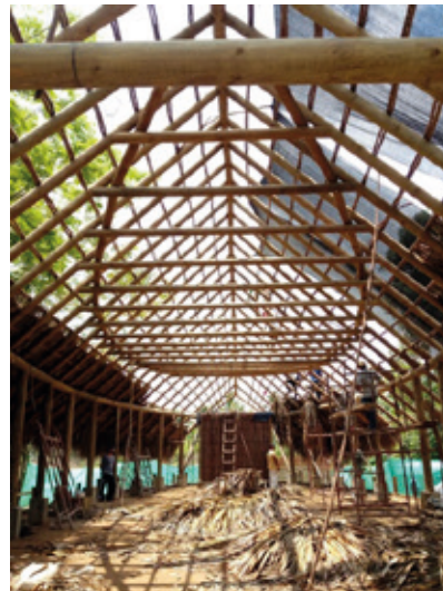
Imagen 44. Centro Cultural en La Mojana, construcción.
