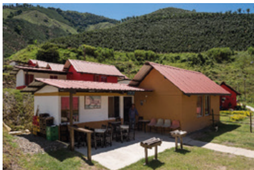
Imagen 550. Viviendas de la Pradera
