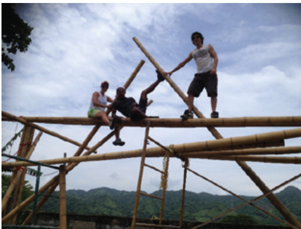
Imagen 3. Casa de la Cultura de Palomino, proceso de construcción.
