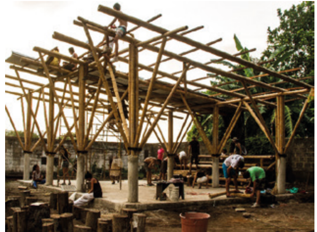
Imagen 4. Casa de la Cultura de Palomino, proceso de construcción.
