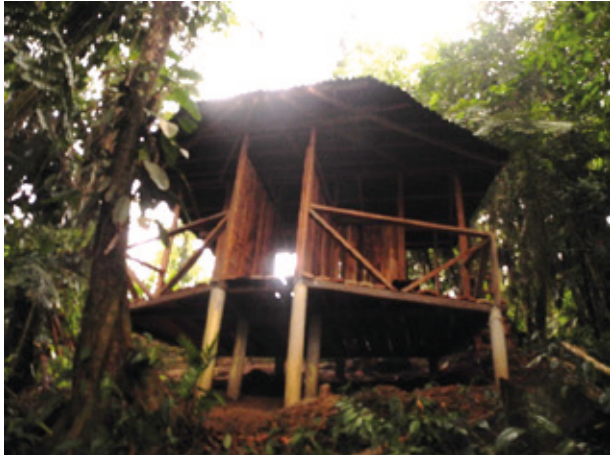
Imagen 23. Cubierta y Baño seco en Ciudad Perdida.
