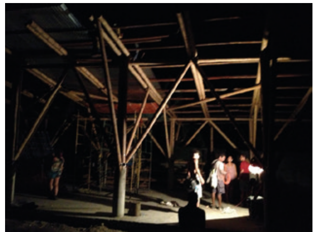
Imagen 5. Casa de la Cultura de Palomino, proceso de construcción.
