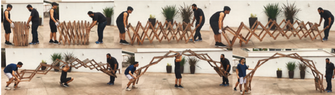
Imagen 258. Mecanismo de transformación – proceso retráctil PABELLÓN “XUÊ”.
