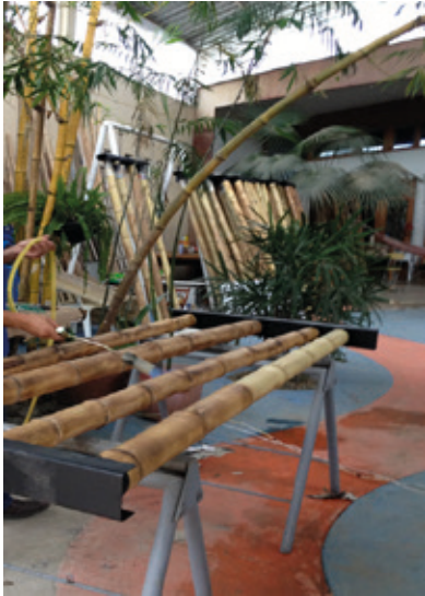
Imagen 91. Construcción, Asadero Rico Pollo.
