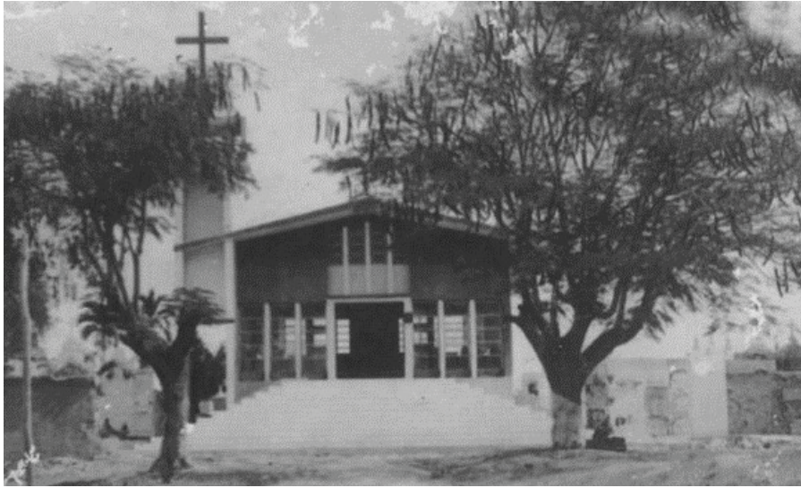
Imagen 44: Fachada principal de la Capilla del Cementerio Central de Sincelejo.
